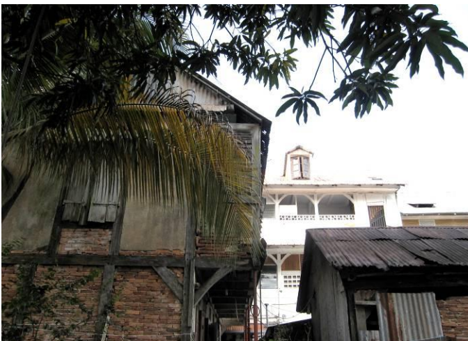
Cayenne, OPAH-RU du centre travaux en cours
