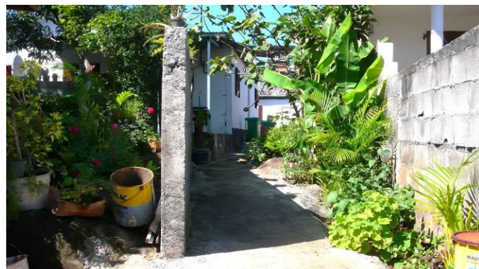
Passage trop étroit – celui qui dessert la maison ci-dessus - pour que les opérateurs acceptent d'intervenir pour améliorer ces maisons ?
