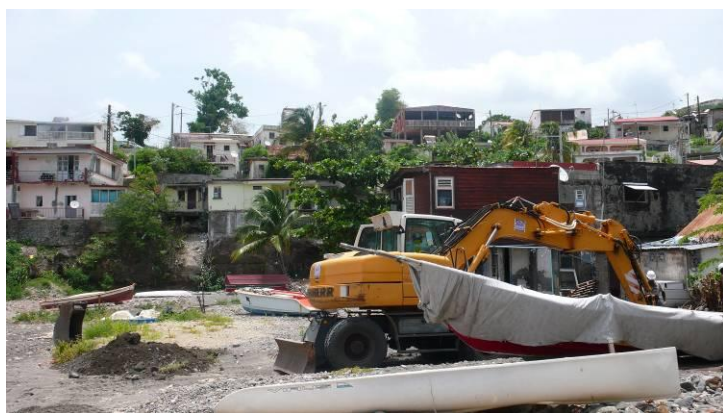
Martinique/travaux de protection à Case Pilote
