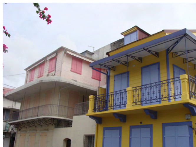
Maisons rénovées à Pointe-à-Pitre, Guadeloupe (S. BOYER)
