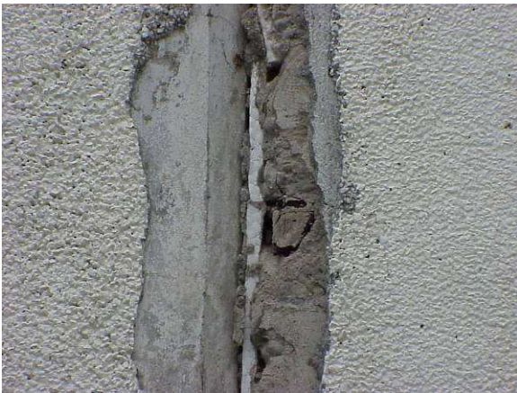
Figure 6-37 : Chi-Chi 1999 – Joint de faible ouverture rempli d'un matériau d'interposition.
