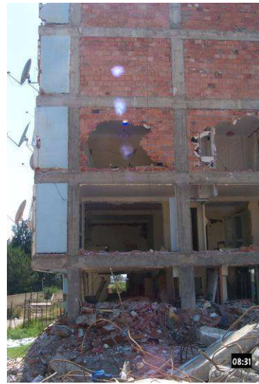
Figure 6-17 : Kocaeli 1999 - Panneaux sollicités perpendiculairement à leur plan.
