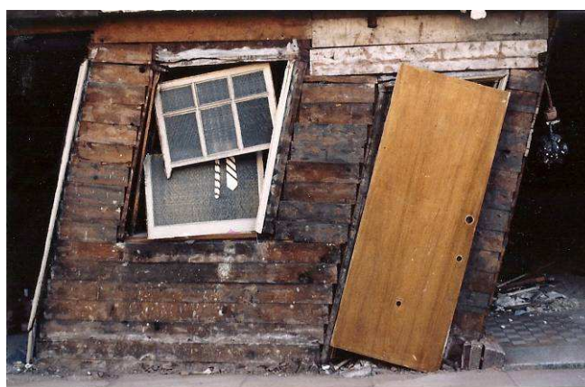
Figure 6-27 : Loma Prieta 1989 – Gros plan sur le rez-de-chaussée du bâtiment de la figure 6-26, illustration de l'absence de contreventement.
