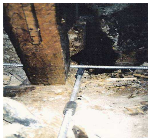
Figure 6-49 : Vue d'un croisement de tirants sous plancher
