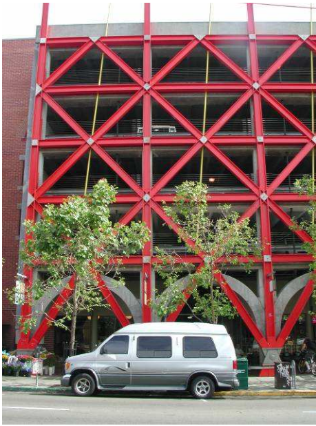
Figure 6-44 : Bâtiment de garages (R+4+Terr) renforcé par l'extérieur par ajout d'une ossature métallique de contreventement
