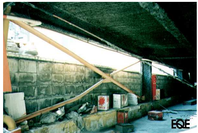
Figure 6-32 : Kobé 1995 – Instabilité des diagonales de contreventement.
