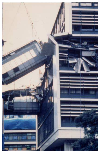
Figure 6-35 : Kobé 1995 – Les passerelles de liaison conduisent à la rupture des éléments verticaux impactés.
