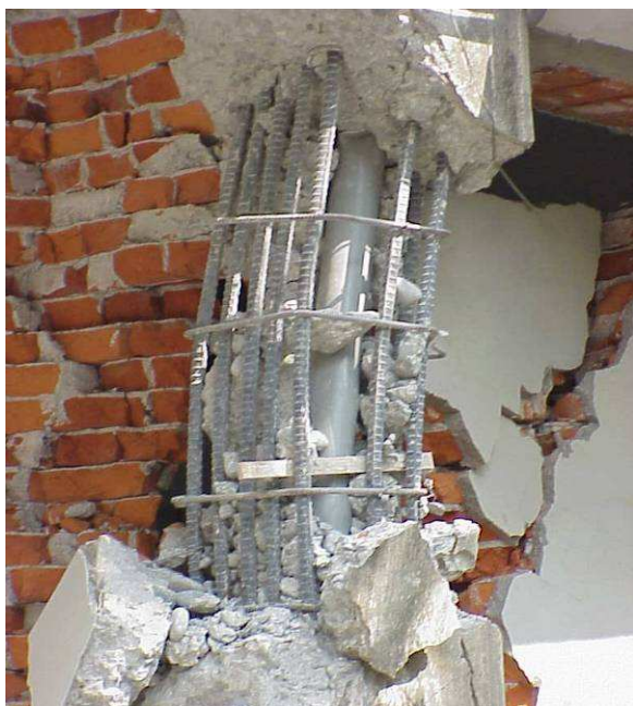
Figure 6-12: Chi-Chi 1999 - Manque de confinement transversal d'un poteau de rive fragilisé par la présence d'une évacuation d'eau pluviale.
