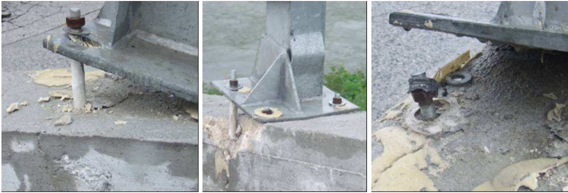
Figure 3-15 : Exemple d’ancrage avec mauvaise adhérence de la cheville chimique (difficile à détecter, si ce n’est la proximité de la cheville avec le nu du mur, ce qui conduit à un ancrage dans une zone de béton non confiné) et trous oblongs surdimensionnés avec rondelles inadaptées (photos mission AFPS L’Aquila, 2009)
