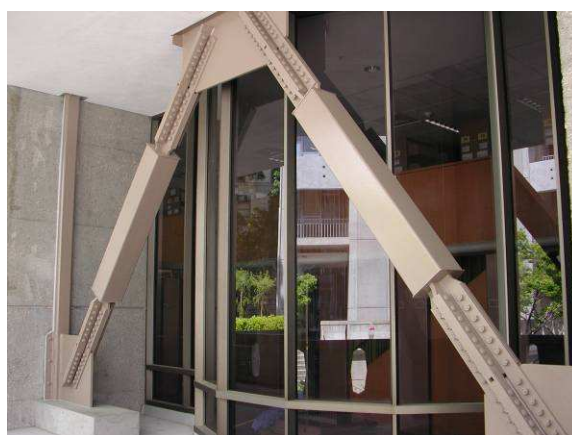
Figure 6-43 : Mise en place d'éléments de stabilité associés à des amortisseurs pour contreventer le niveau rez-de-chaussée de ce bâtiment R+2
