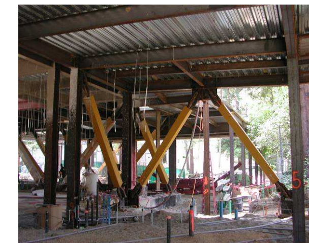
Figure 6-45 : Contreventement réalisé par des diagonales associées à des amortisseurs
