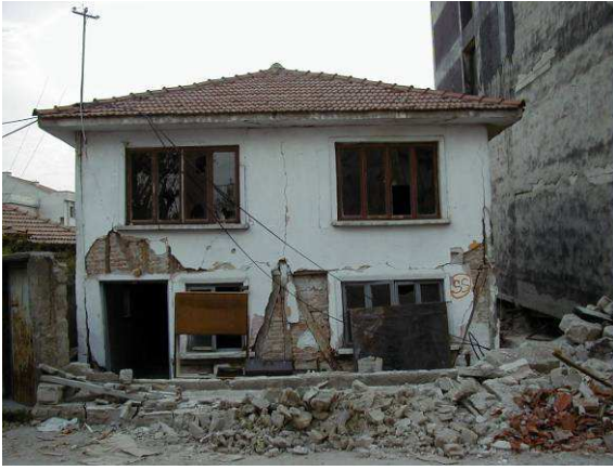
Figure 6-29 : Kocaeli 1999 – Maison individuelle à ossature bois et remplissage en briques dans l'épaisseur de l'ossature. La conception est régulière, le remplissage participe au contreventement.
