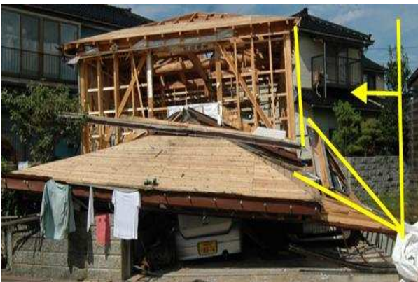
Figure 6-31 : Chetsu-Oki 2007 – Maison individuelle : insuffisance de contreventement.
