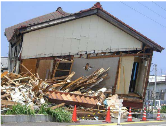
Figure 6-30 : Chetsu-Oki 2007 – Maison individuelle : insuffisance de contreventement.
