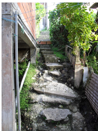
Un accès difficile à un logement réhabilité, Fort-de-France
