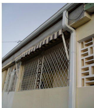
Une gouttière mise en place dans le cadre d'un dossier AAH Fort-de-France
