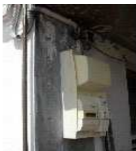
Un écoulement d'eau sur un compteur électrique, dans un logement avant réhabilitation
